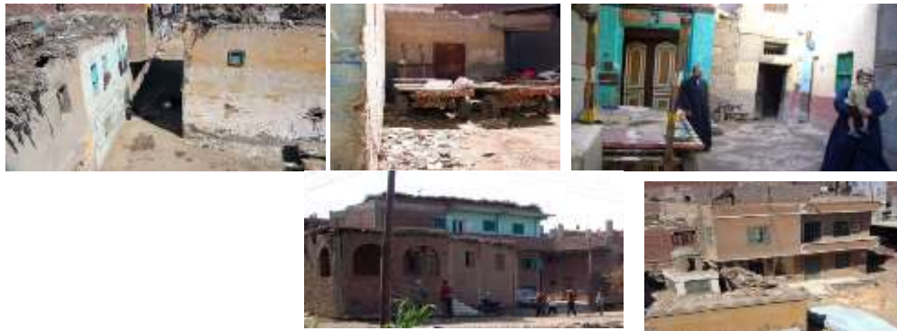
شكل (4) لقطات توضح بعض واجهات المرحلة الأولى. المصدر: الباحث.
